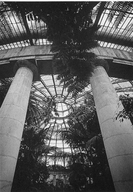
De door een architraaf verbonden zuilencirkel is de neoclassicistische handtekening van de architect.
