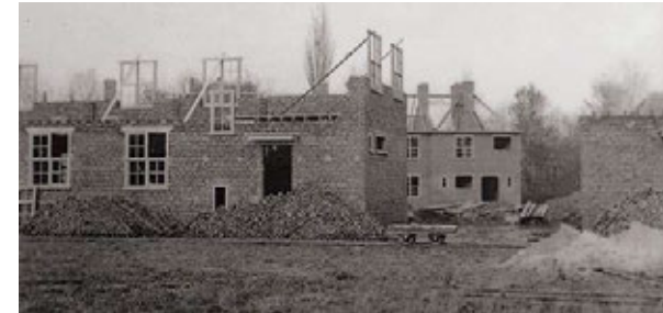
Nog andere nieuwe bouwtechnieken werden toegepast. In de gevels werden kleine zelfdragende ramen geplaatst en tegelijkertijd gemonteerd met het metselwerk. Deze gestandaardiseerde elementen verlaagden de productie- en de bouwkosten. Le Logis. Foto z.d.
