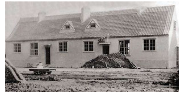
De ter plaatse vervaardigde bakstenen waren van onvoldoende kwaliteit om te worden gebruikt als gevelsteen en hadden een beschermlaag nodig. De ruwe bepleistering maakt het volume van de huizen eenvormig en onttrekt de verschillende materialen aan het oog. Kruisbooglaan, Le Logis. Foto's 1922-1923.
