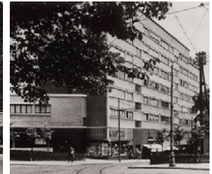
Lijstvensters, eenvoudig balkvolume zonder versieringen, bepleistering op een betonnen skelet en spel van keramiektegels. Het Sociaal Centrum van Le Logis is een typerend voorbeeld van de nieuwe architecturale taal van het modernisme. Arch. J.-J. Eggericx, 1930-1933. Foto's, 1933.
