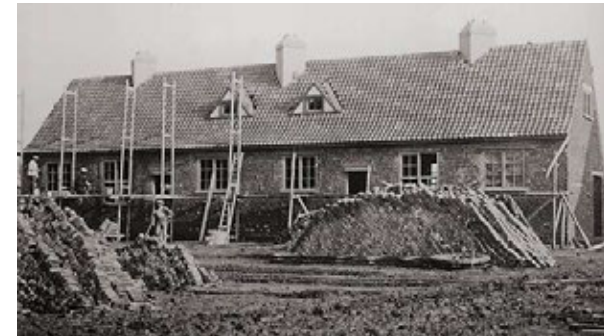
Nog andere nieuwe bouwtechnieken werden toegepast. In de gevels werden kleine zelfdragende ramen geplaatst en tegelijkertijd gemonteerd met het metselwerk. Deze gestandaardiseerde elementen verlaagden de productie- en de bouwkosten. Le Logis. Foto z.d.
