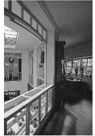
Op de eerste verdieping diende de galerij, belicht door een venster boven de portiek, als werkruimte voor de architect. De beglaasde wandkasten, die de rol van balustrade vervullen, dienden voor het opbergen van boeken en kunstvoorwerpen.
