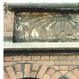
Voorbeeld van de aftakeling van een sgraffito : op tijd ingrijpen is de boodschap!
