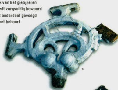
De stalen schoenen zijn volledig gecorrodeerd en moeten worden vervangen
