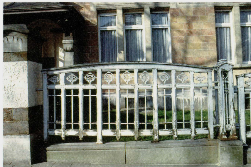
Ieder stuk van het gietijzeren decor wordt zorgvuldig bewaard en bij het onderdeel gevoegd waartoe het behoort
