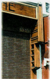
Het hout is volledig blank geschuurd alvorens te worden gevernist
