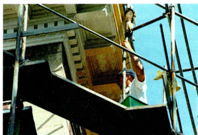
Herschilderen na afbijten of afbranden van de verf voorbeelden van aantasting
