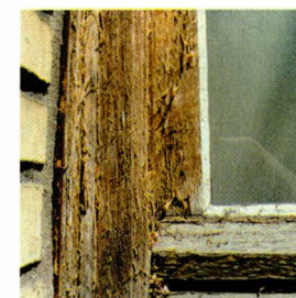
Aftakeling van het vernis wegens slechte verwijdering van het afbijtmiddel
