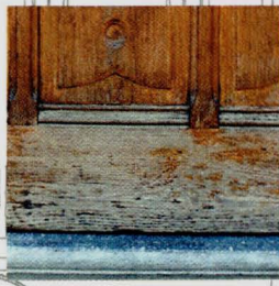
Aantasting van de onderkant van de deur
