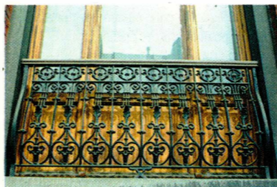
Borstwering uit gebogen gietijzeren elementen
