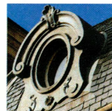
Dakkapel bekleed met gedreven koper
