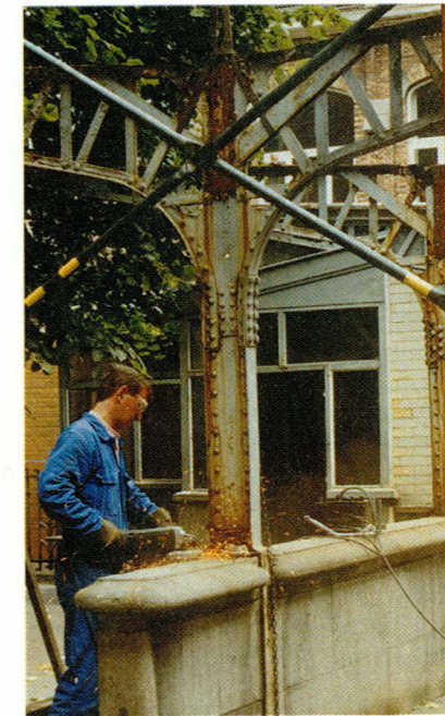
Demontage: de in een stenen sokkel verzonken palen moeten worden afgezaagd
