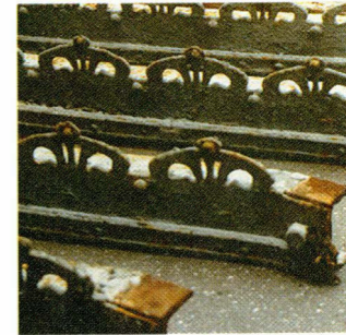
Plan en detail van de siermotieven van de luifel na demontage
