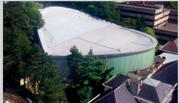
L'auditoire est implanté à l'arrière de l'ancienne Maison des Etudiants, édifié par Alexis Dumont le long de l'avenue Franklin Roosevelt à Bruxelles. Het auditorium werd dus achter het studentenhuus gebouwd, die ontworpen waren door Alexis Dumont, langsheen de Franklin Rooseveltlaan in Brussel. (© SPBR - GCB) Reproduction interdite.
