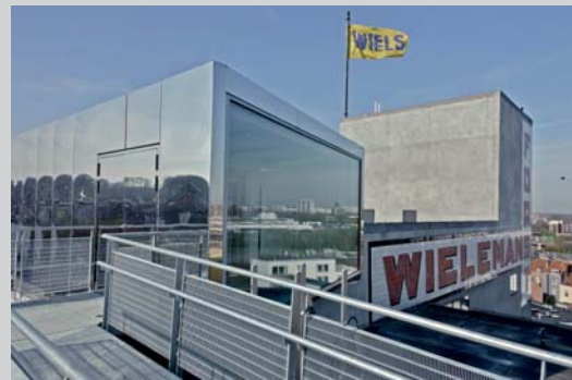
Beliris a récemment entrepris des travaux d'isolation au Centre d'Art Contemporain afin d'améliorer les prestations énergétiques du bâtiment. Beliris heeft zojuist het Centrum voor Hedendaagse Kunst geïsoleerd met het oog op het optimaliseren van de energieprestaties van het gebouw. (Alfred de Ville de Goyet © SPBR - GC8)
