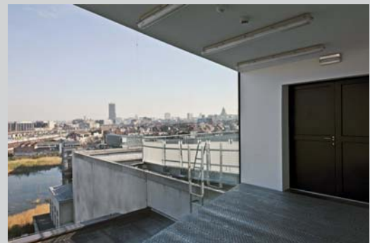
Le projet concerne entre autres la création d'un accès (vitré) vers la terrasse panoramique en toiture. Het project betreft onder meer de constructie van een nieuwe glazen toegang tot het panoramisch dakterras. (Alfred de Ville de Goyet © SPBR - GC8)
