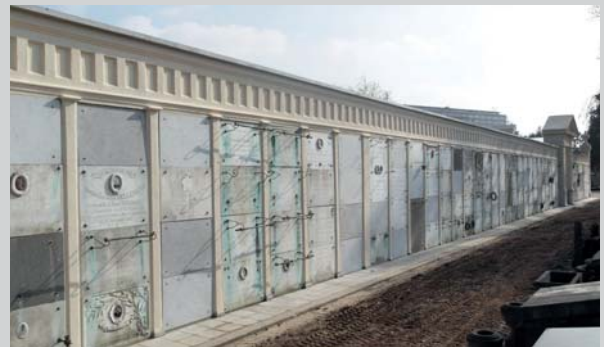
Vue sur l'extérieur de l'axe central, après la restauration.
