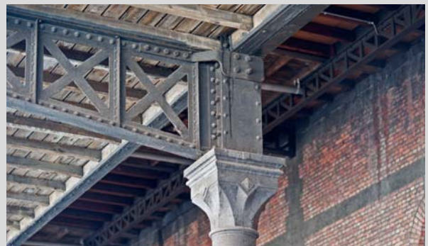
Chapiteaux d'une des colonnes soutenant la toiture du quai. Kapiteel van een van de kolommen die het dak van het perron dragen. (A. de Ville de Goyet © SPFB - ©2018)
