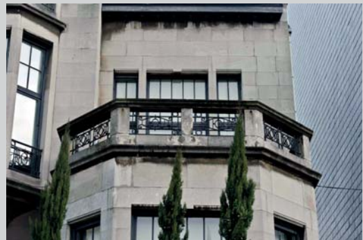
La façade à rue a été modifiée en 1924 en style Art Déco. De straatgevel werd in art-decostijl gewijzigd in 1924. (Alfred de Ville de Goyet © SPRB - GCB)
