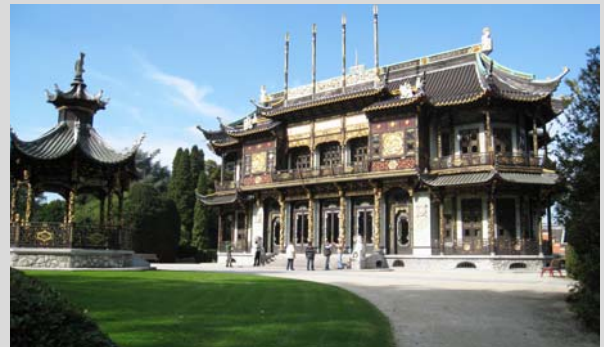
Le pavillon chinois, avenue Van Praet, arch. A. Marcel (1901-1910). Chinees Paviljoen, Van Praetlaan, arch. A. Marcel (1901-1910). (Photo / foto © SPRB / GCB)
