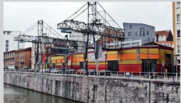
Les deux portiques du quai du Hainaut. De twee portieken aan de Henequouwenkaai. (A. de Ville de Goyet, 2015 © SP98 - GC18)
