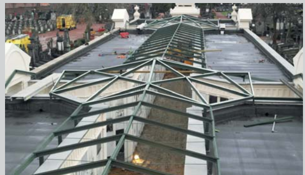
Vue aérienne de l'axe central pendant le montage de la structure métallique de la verrière.
