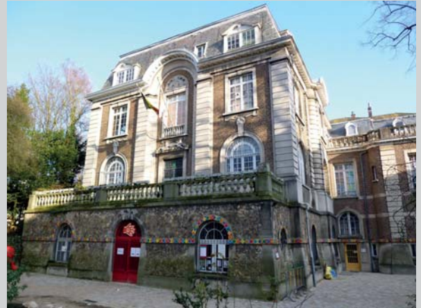
L'ancienne propriété d'E. Canonne actuelle Musée des enfants à l'entrée du parc Jadot : situé rue du Bourgeois, 15 à 1050 Ixelles. (Photo © SPBR) Het voormalige goed van E. Canonne is nu een Kindermuseum bij de ingang van het park Jadot : gelegen Burgemeesterstraat 15 in 1050 Elsene. (Foto © GCB)
