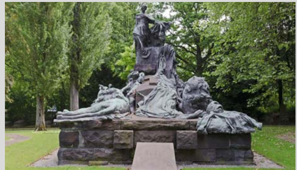
Vue du mémorial de la bataille de Waterloo, après les travaux de restauration. Het Waterloo-Memorial na restauratie. (A. de Ville de Goyer © SPRB-GC18)
