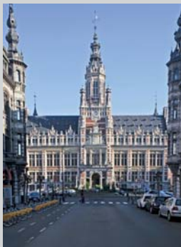
Hôtel communal de Schaerbeek, Place Colignon 1. Gemeentehuis van Schaerbeek, Colignonplaats 1. (Allied de Ville de Goyet © SPRB - GCB)
