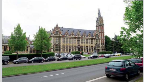
Bâtiment A, façade principale, avenue Franklin Roosevelt. Gebouw A, voorgevel Franklin Rooseveltlaan. (Alfred de Ville de Goyet © SPRB - GCB)
