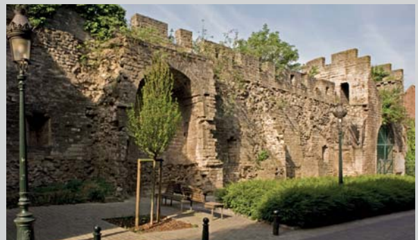
La première enceinte. De eerste omwalling. (Photo / foto © SPRB / GCIB)
