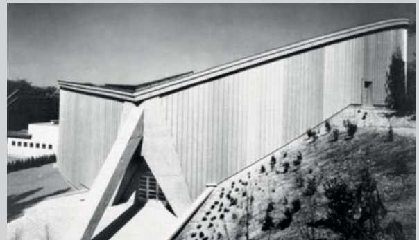
Côté latéral de l'auditorium Paul-Émile Janson, bâtiment J (l'architecte M. Van Goethem, œuvres et études, 1940-1959, Bruxelles, s.d., p. 49). Kant zij van het auditorium Paul-Émile Janson, gebouw J (de architect de Heer Van Goethem, werken en studies, 1940-1959, Brussel, s.d., p. 49). (© SPBR - GCB) Reproduction interdite.
