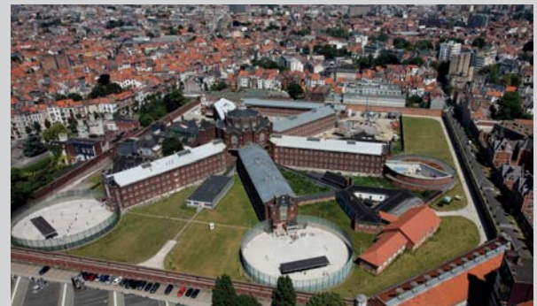
Vue aérienne de la prison Luchtfoto van de gevangenis
