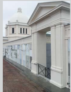
Vue sur la coupole depuis l'extérieur de l'axe central, après la restauration.
