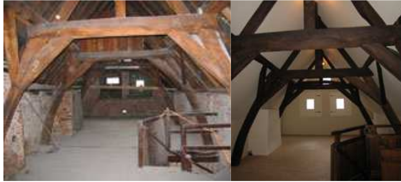
Hoofdgebouw - zolder - vóór en na de restauratie
