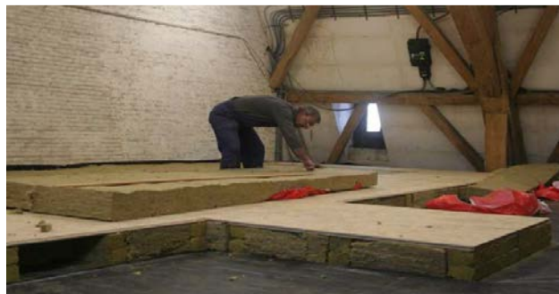
Tijdens de werkzaamheden - november 2011
