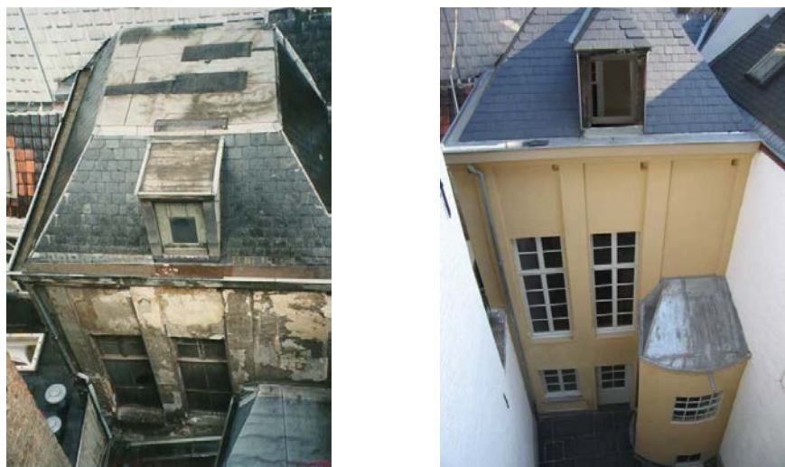
Achterhuis - achtergevel - vóór en na de restauratie
