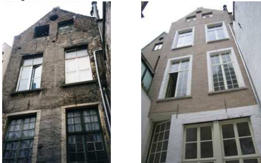
Hoofdhuis - achtergevel - vóór en na de restauratie
