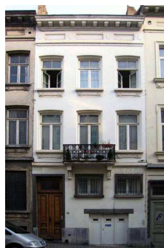
Brussel, Mercelisstraat 72. Ondanks de zware ingeep op de benedenverdieping is dit gebouw weerhouden binnen een homogene straatwand. In een andere context werd het mogelijk niet weerhouden.
