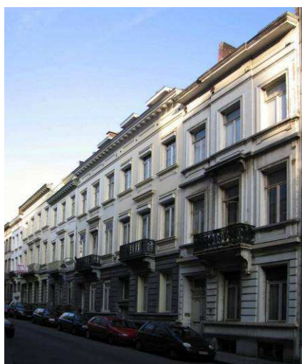
Brussel, Mercelisstraat 70 tot 80. Homogene straatwand door aannemers Labarre, 1866-1873.
