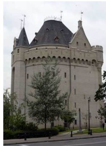
Brussel, Hallepoort: correctieve restauratie
