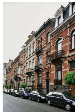
Elsene, Generaal Pattonstraat 27 en volgende. Homogene straatwand in eclectische stijl n.o.v. verschillende architecten, jaren 1900.
